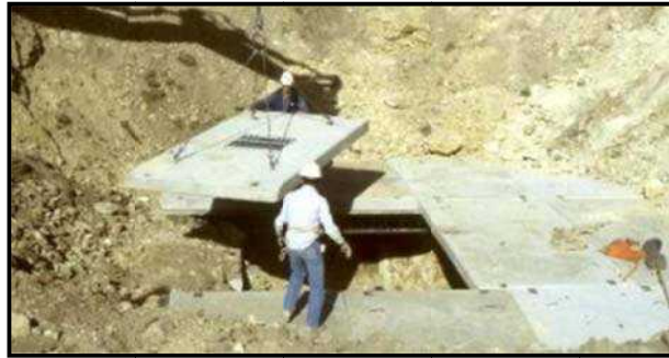
شکل ۲-۹- بستن چاه با سرپوش بتنی قابل برداشت
