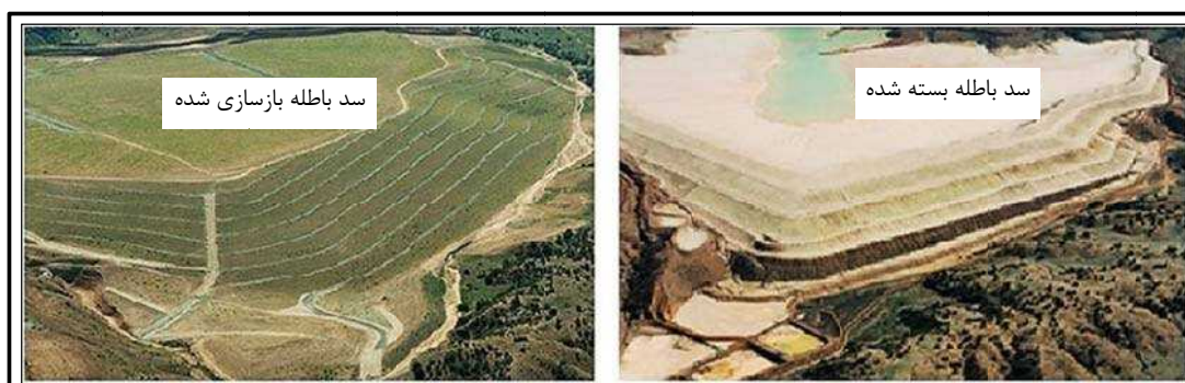
شکل ۳-۹- نمونه‌ای از سد باطله بازسازی شده با گیاه‌کاری پس از بستن
