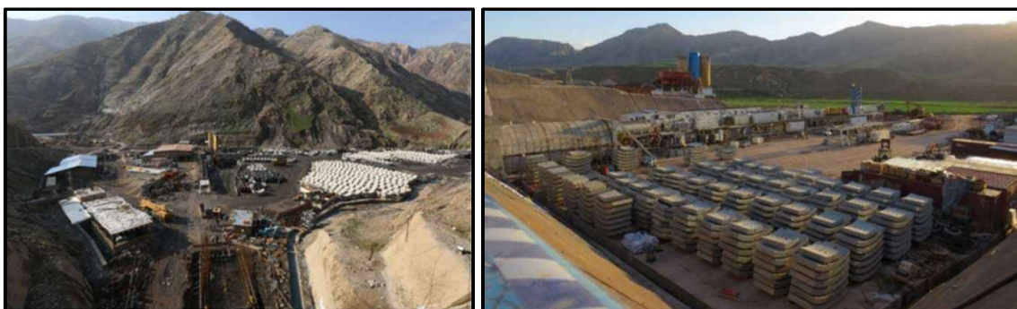
شکل ۵-۳- نمونه جانمایی تجهیز کارگاه در ورودی تونل مکانیزه انتقال آب بلند زاگرس و تونل شماره ۴ پروژه گرمسیری
