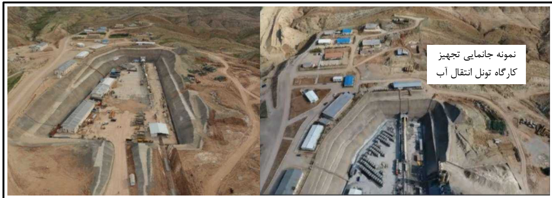
شکل ۵-۱- نمونه جانمایی تجهیز کارگاه و راه‌های دسترسی تونل مکانیزه انتقال آب در پورتال ورودی در پروژه بازی‌دراز
