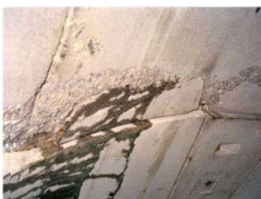
خردشدگی سگمنت در هنگام جا زدن
