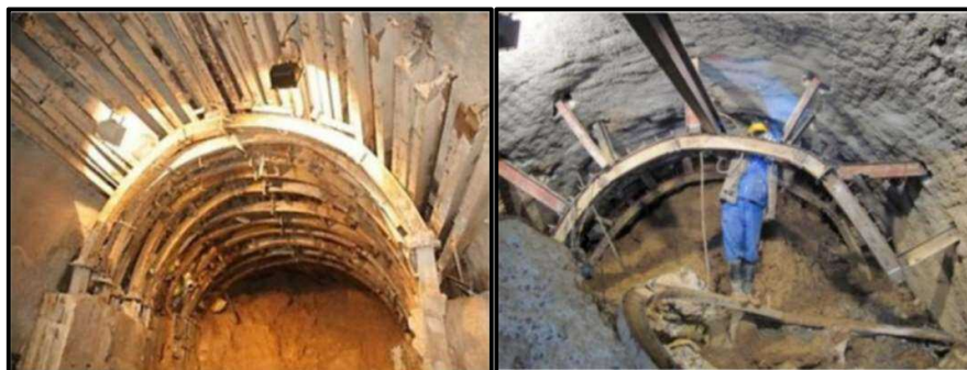
شکل ۳-۱۳- نصب پروفیل در طول تونل برای کمک به سامانه نگهداری قاب در محل مستعد ریزش
