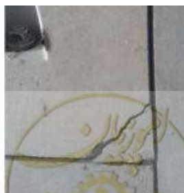
شکستگی گوشه سگمنت کلید حین جا زدن
