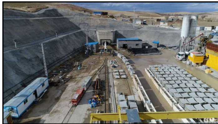
شکل ۵-۲- نمونه جانمایی تجهیز کارگاه تونل انتقال آب آزاد شامل دیو موقت سگمنت و تدارکات اجرایی در ورودی تونل
