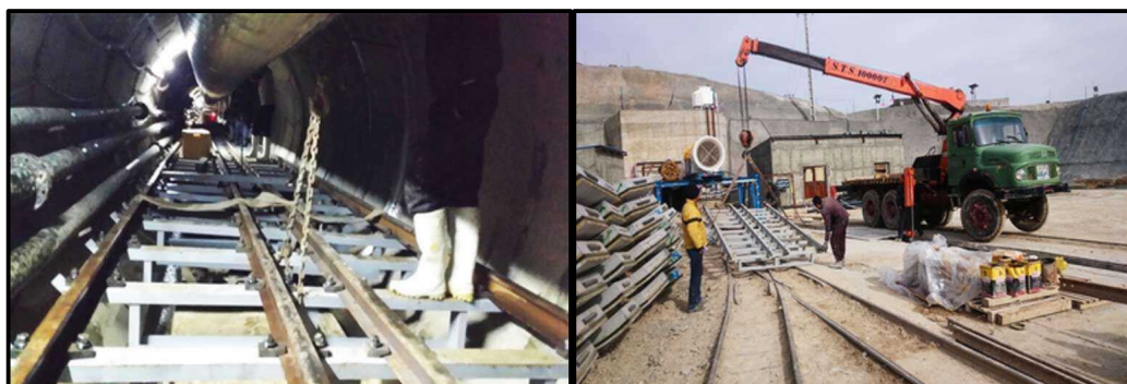
شکل ۵-۱۰- حمل و نصب قطعات ریل در خارج و داخل تونل در تونل انتقال آب سد آزاد
