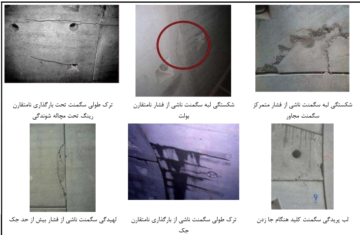
شکل ۶-۶- انواع آسیب سگمنت و علل آن
