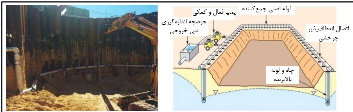
شکل ۵-۲- خشک‌اندازی ترانشه حفاری به روش چاه‌های زهکشی
