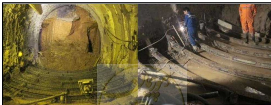
شکل ۳-۱۴- نصب کف‌بند قاب برای نواحی مستعد مچاله‌شوندگی و هم‌گرایی زیاد در تونل انتقال آب سبزکوه
