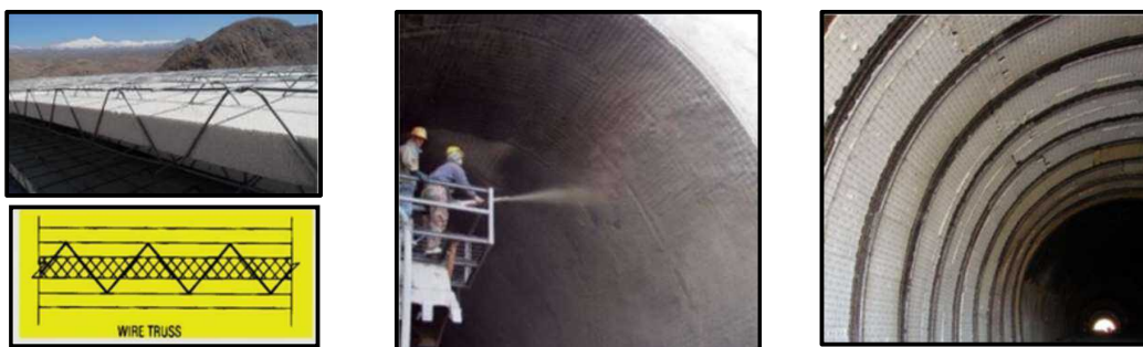
شکل ۳-۱۶- استفاده از پانل ساندویچی مخصوص بافته شده با فوم میانی به عنوان سامانه نگهداری و قالب درجا
