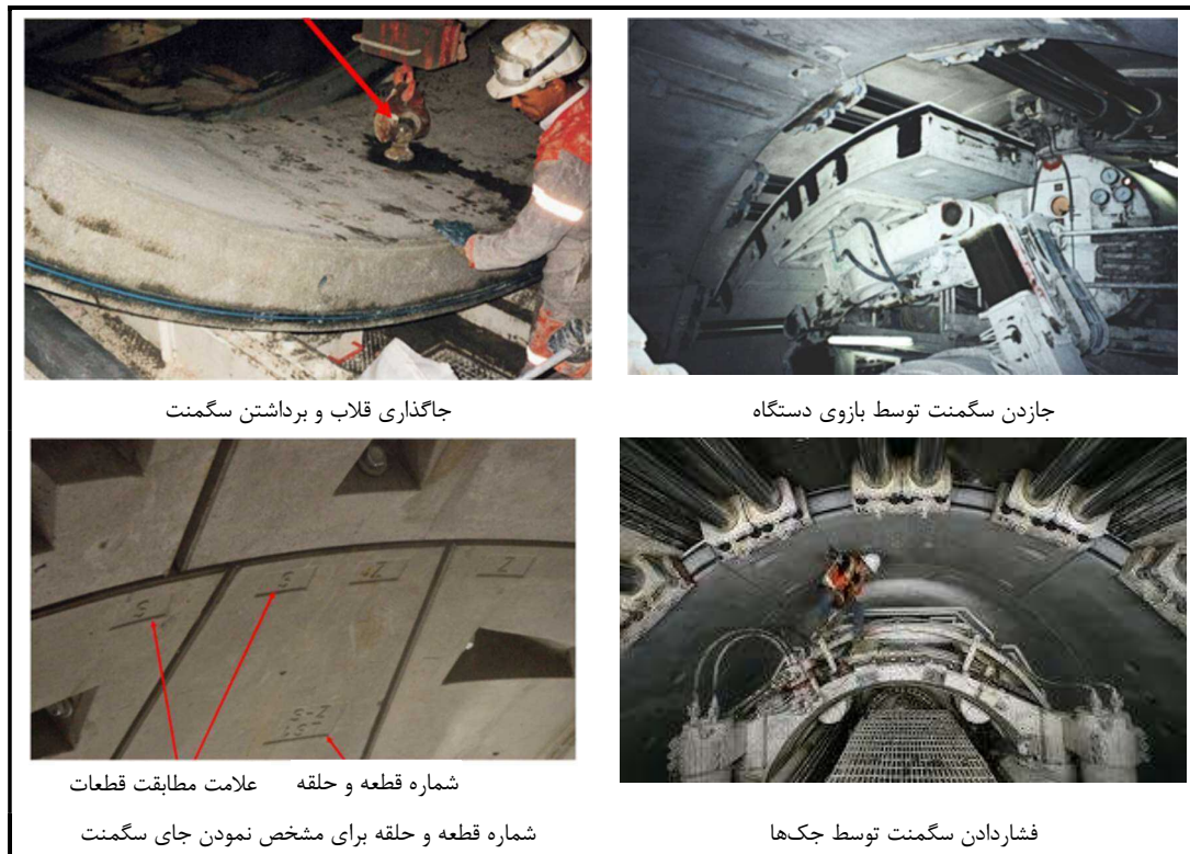
شکل ۶-۸- فرآیند نصب و جاذدن سگمنت
