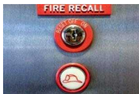
شکل ۶-۳۰- نمونه‌ای از کلید آتش‌نشانی
